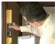
柱・壁の傾斜計測
