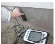
基礎の配筋調査
