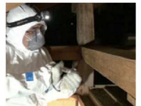
天井裏の調査
