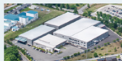
秩父セキュリティ 第3センター/令和棟 (長谷工コーポレーション施工 2019年8月竣工)
